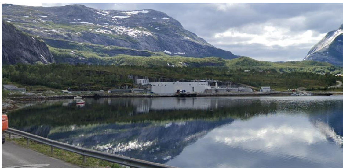
Bildet viser dagens situasjon - smoltanlegg. Det er høy fjellskjæring i bakkant av fabrikk, deler av området er utbygd på utfylling i sjø.
