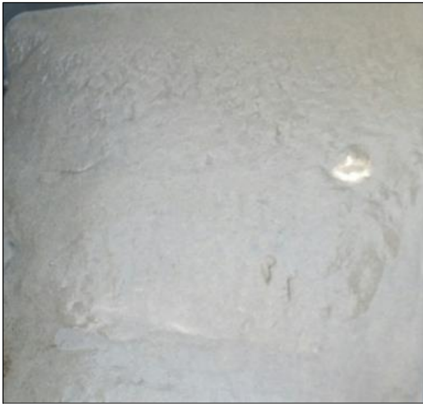
Figur 7: Stasjon M2. Foto: Rambøll, 2019.
