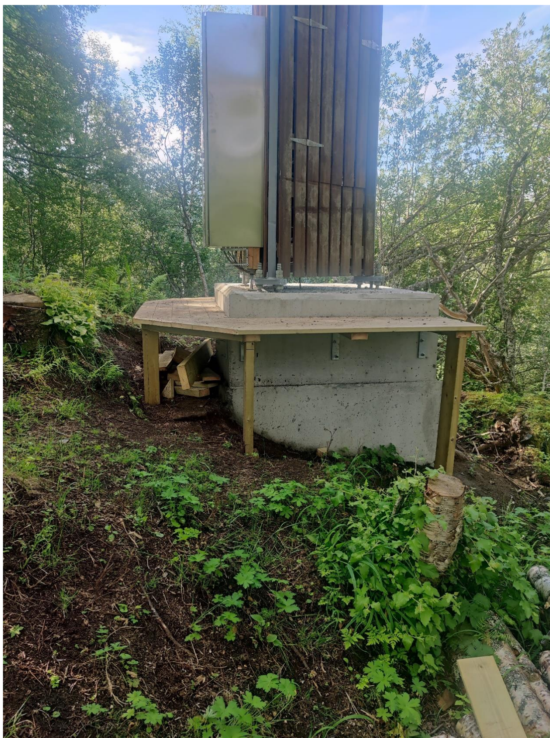
Mast er etablert med sokkel i betong, som er forankret ned i fast fjell. Det har vært fokus på å gå skånsomt frem i naturen.
