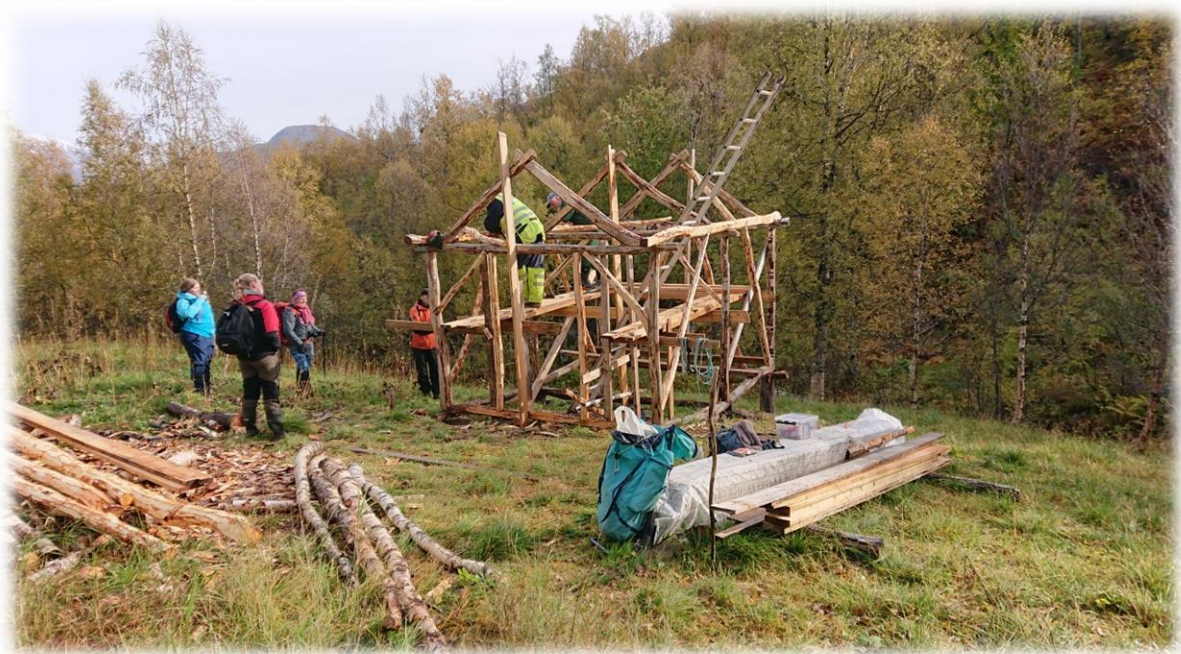
Figur 12: Sjytte under bygging i Kjelvik. Foto av Gerd Bente Jakobsen.
