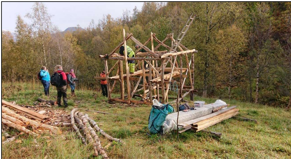
Ny høysjytte under bygging i Kjelvika. Foto: Gerd Bente Jakobsen.
