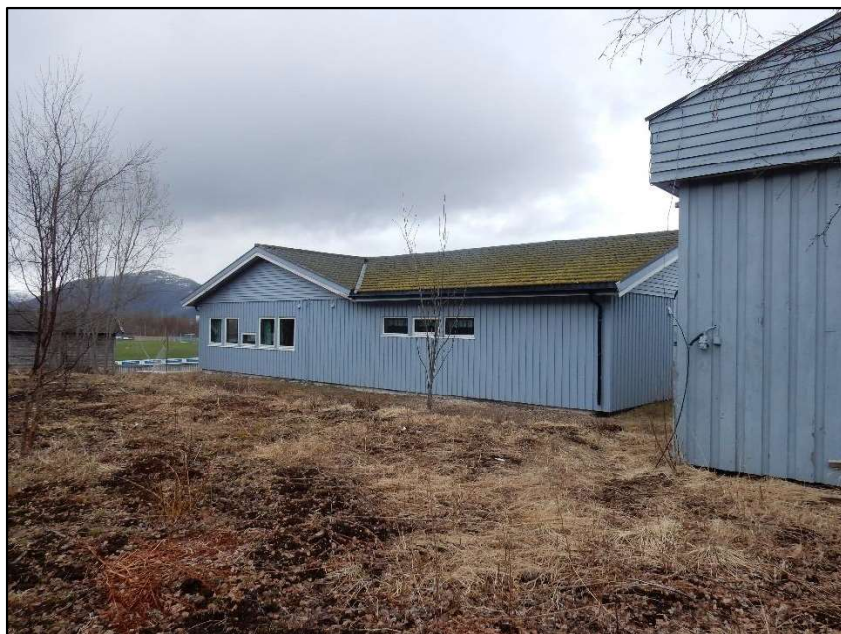
Garderobebygget ved Lakselva idrettsanlegg fikk utvendig maling i 2020.
