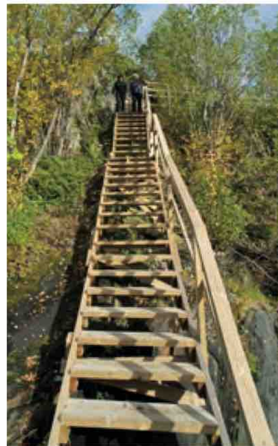
Trappa ned til tunellen. Foto: Kjell Fredriksen.
