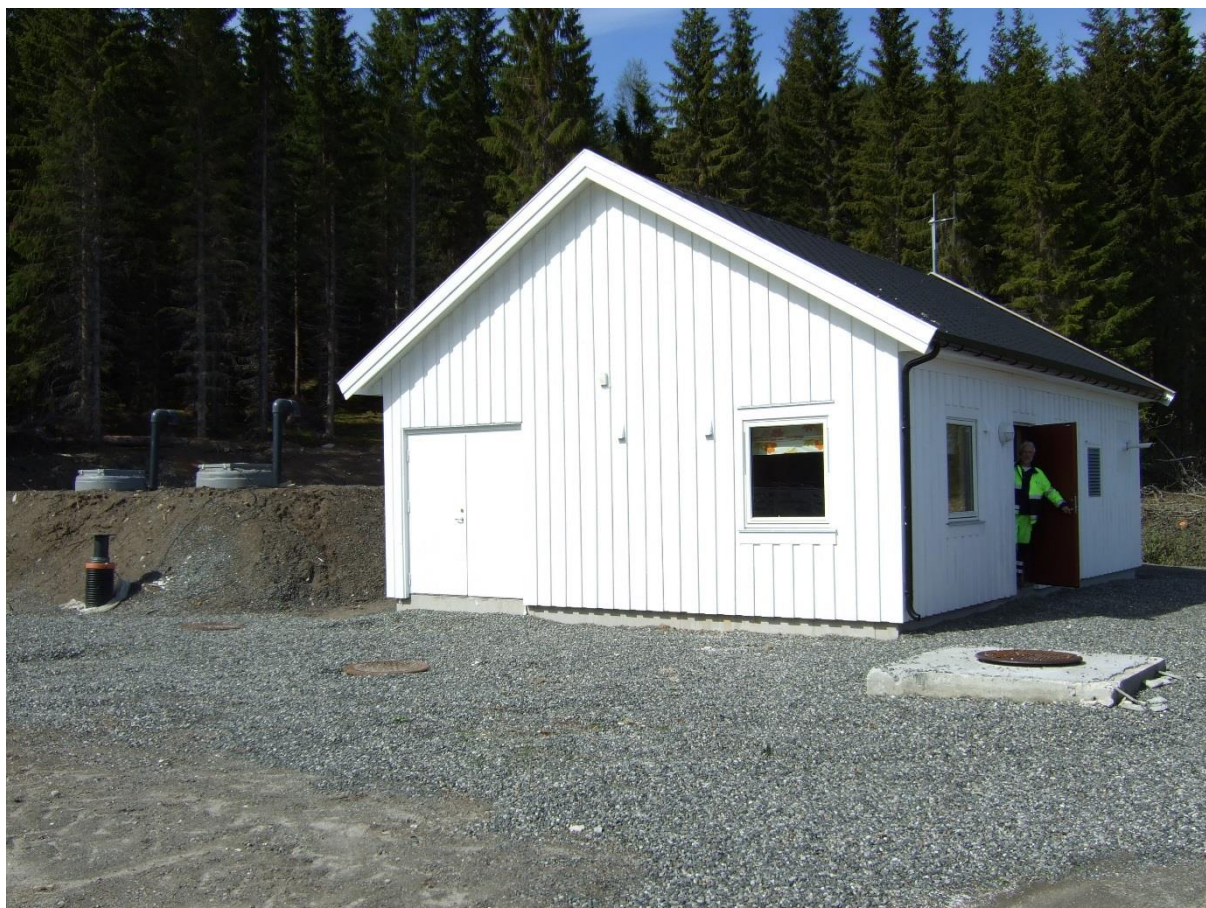
Figur 3 Røsvik vannverk – Vannbehandlingsanlegget
