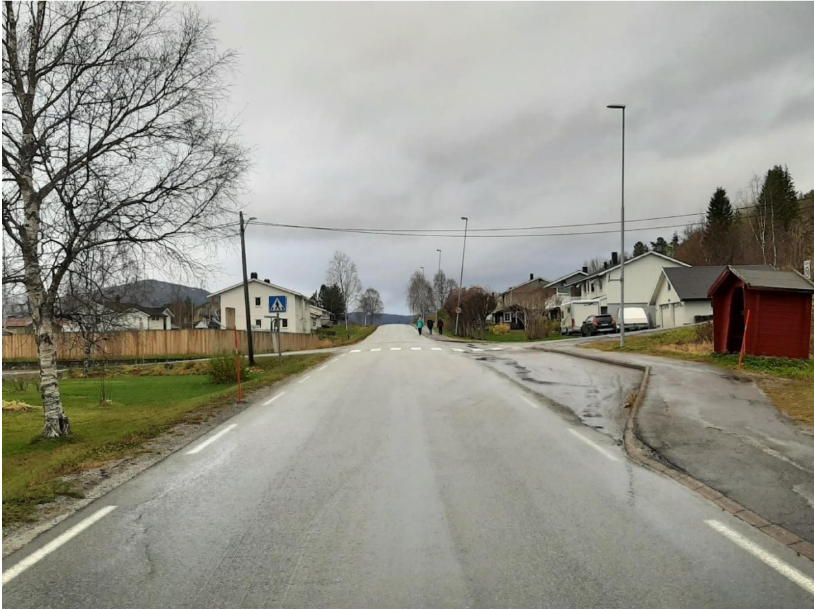
Eksisterende bussholdeplass. Planområdet har allerede etablert ensidig fortau, men som i gjeldende plan er regulert smalere enn ønsket bredde.
