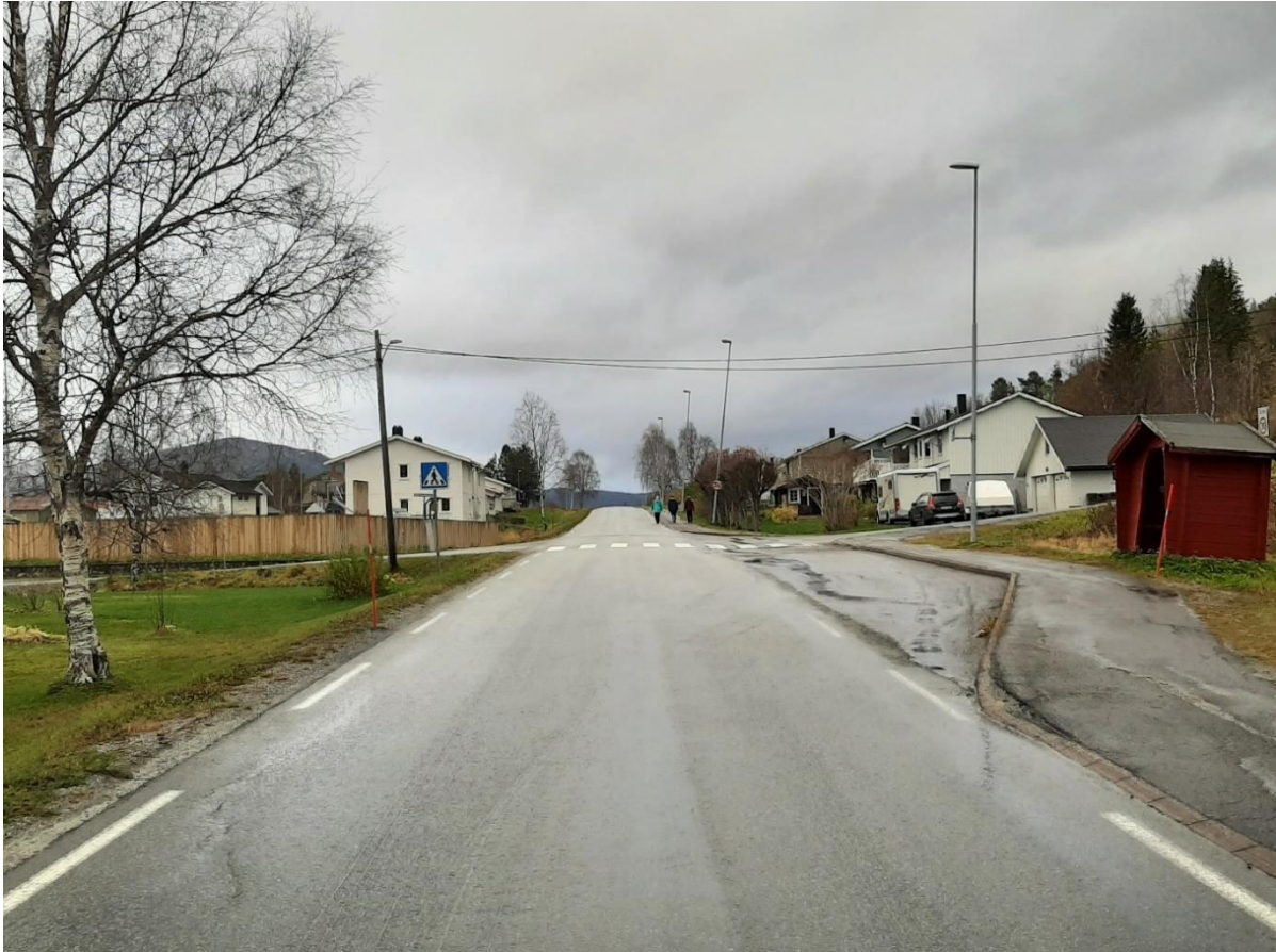
Eksisterende bussholdeplass. Planområdet har allerede etablert ensidig fortau, men som i gjeldende plan er regulert smalere enn ønsket bredde.
