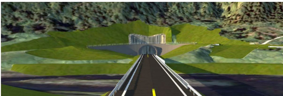
Figur 54: Tunnelportalen i Megården skal omrammes av tørrsteinsmur.
