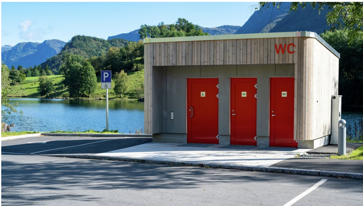
Figur 57: Toalettbygget på rasteplass E134 ved Haukalivegen
