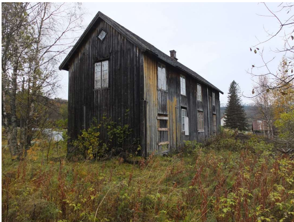
Figur 7. Den bestående bygningen Åkerveien 4 sett fra øst. Foto Gisle Jakhelln okt. 2018.
