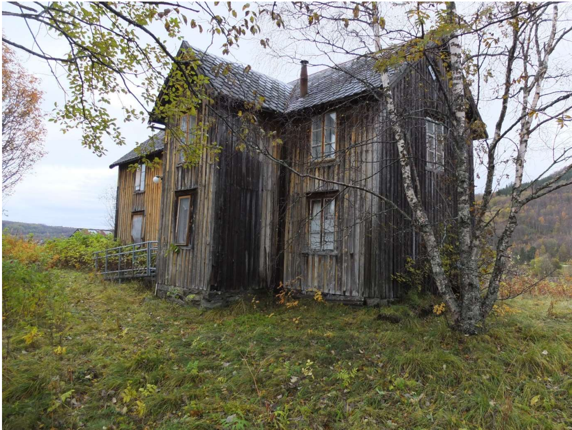
Figur 14. Åkerveien 4 sett fra syd. Godt eksempel på nordlandshus med senere på- og tilbygg. Foto Gisle Jakhelln okt. 2018.
