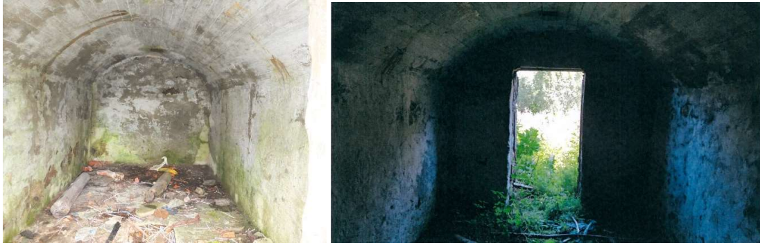
Figur 18. Tysk bunker/oppholdsrom. Foto: Gisle Jakhelln oktober 2018
