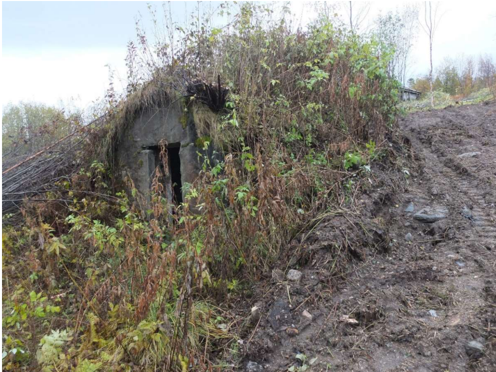
Figur 11. Tysk bunker/oppholdsrom fra 2. verdenskrig i nedre del av tomten, sett mot øst. Foto: Gisle Jakhelln okt. 2018.
